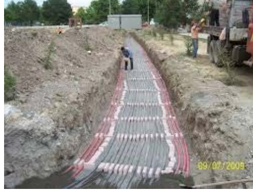
Resim 12 ve 13: Yağmursuyu boru hattı ve elektrik hattı hendek çalışması
