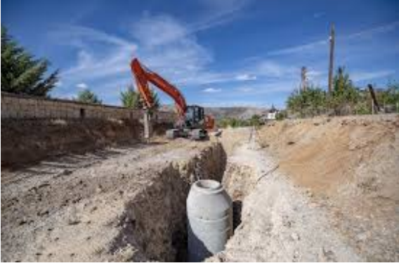
Resim 12 ve 13: Yağmursuyu boru hattı ve elektrik hattı hendek çalışması
