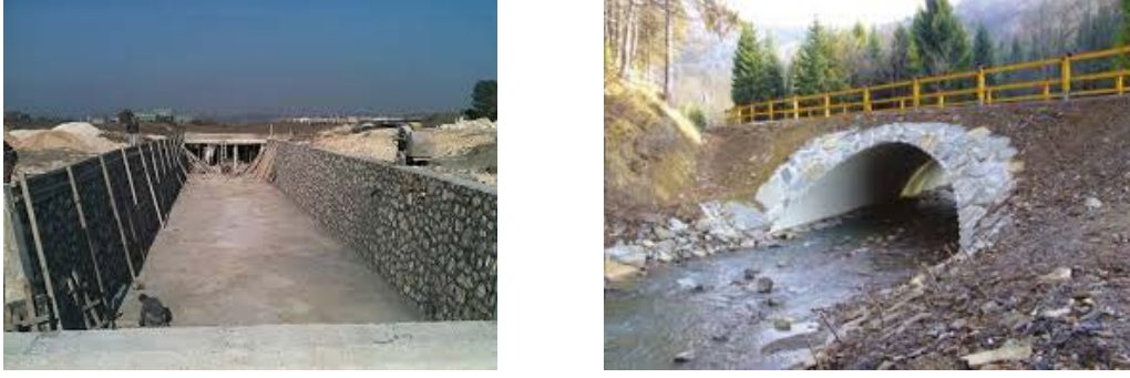
Resim 10 ve 11: Dere ıslahı ve menfez yapısı
