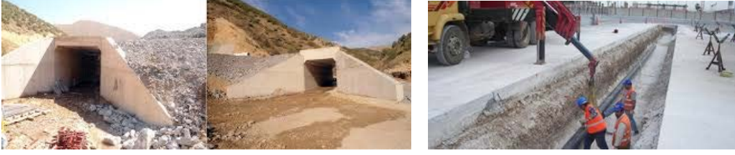
Resim 8 ve 9: Menfez ve boru hattı hendek yapım çalışmaları
